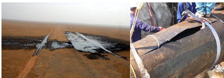
Figure 4 : Vues de l'épandage et de l'ouverture sur la canalisation, accident sur une canalisation de transport de pétrole brut à Saint-Martin-de-Crau (Bouches-du-Rhône) le 7 août 2009 (source : www.aria.developpement-durable.gouv.fr )
