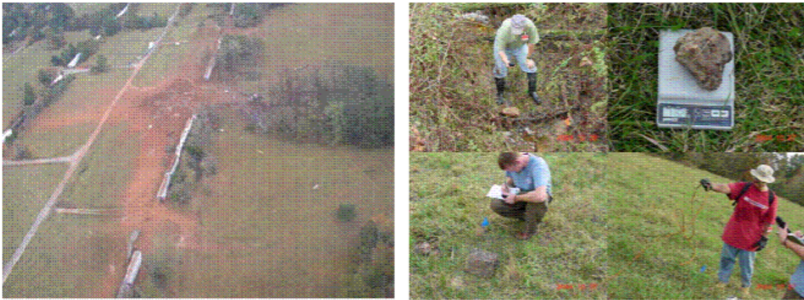
Figure 16 : Photos du dépôt MILAN après accident
