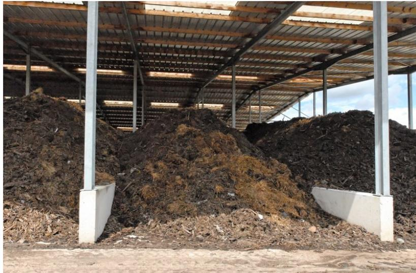
L'installation comprend 14 casiers de 24×5 m, placés sous hangar. La fermentation en casier dure 4 semaines au minimum, sans retournement. L'aération forcée est mise en marche par intermittence une heure sur deux, avec un débit de 250-300 m<sup>3</sup>/h (chiffre donné par l'exploitant). Après fermentation, le compost est criblé puis stocké à l'extérieur. Les refus de criblage sont recyclés comme structurant.
