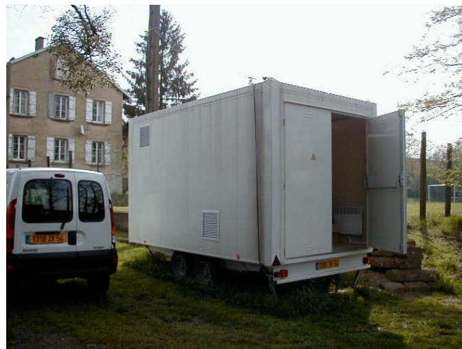
Photo 4 : station de mesure installée à Morlange
