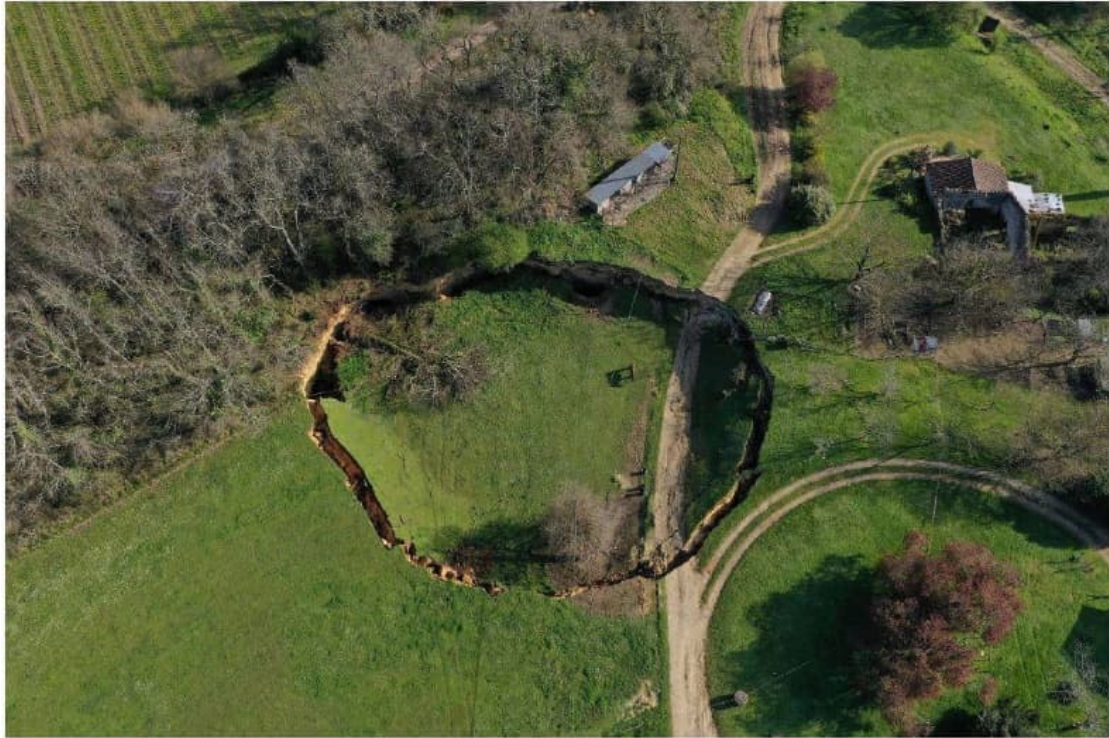
Photographie 1 : Vue aérienne de l'effondrement généralisé (cliché A. Methez, CD33-DI)
