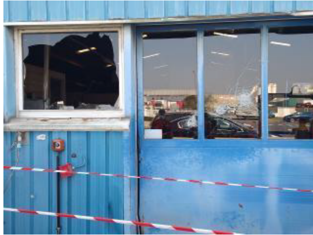
Figure 6 : Entrée AEB coté banc de test
