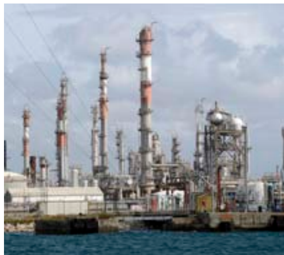
Exemple d'un site classé ICPE : la raffinerie de Fos-sur-Mer, dans les Bouches-du-Rhône.
