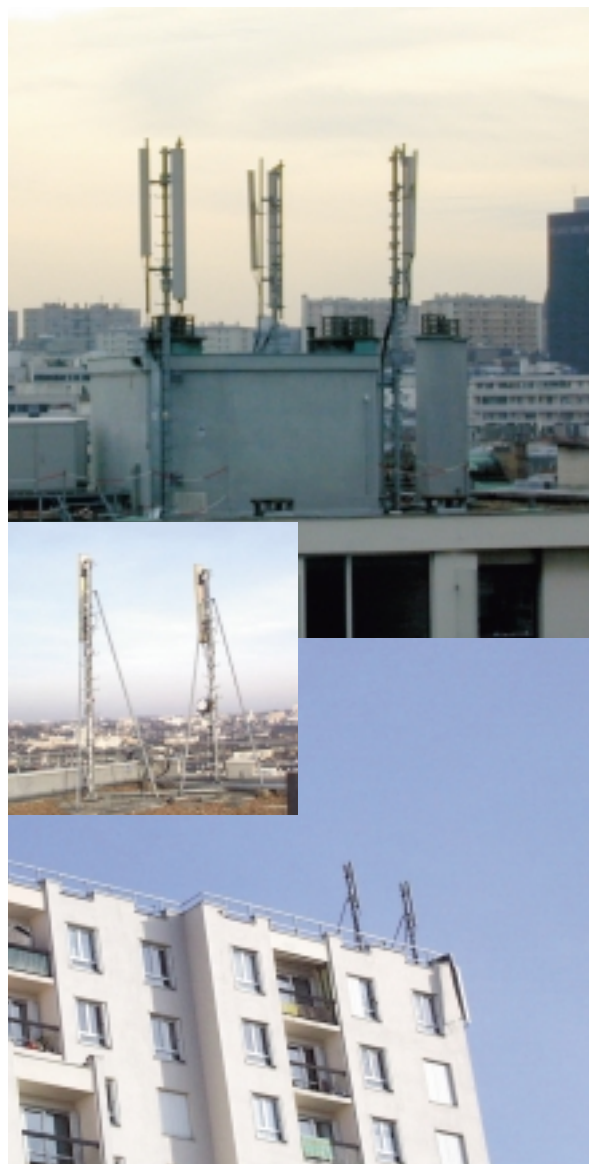
À 1,5 m des antennes micro-cellulaires et à 2,5 m des antennes macro-cellulaires, il n'y a pas de danger démontré.
