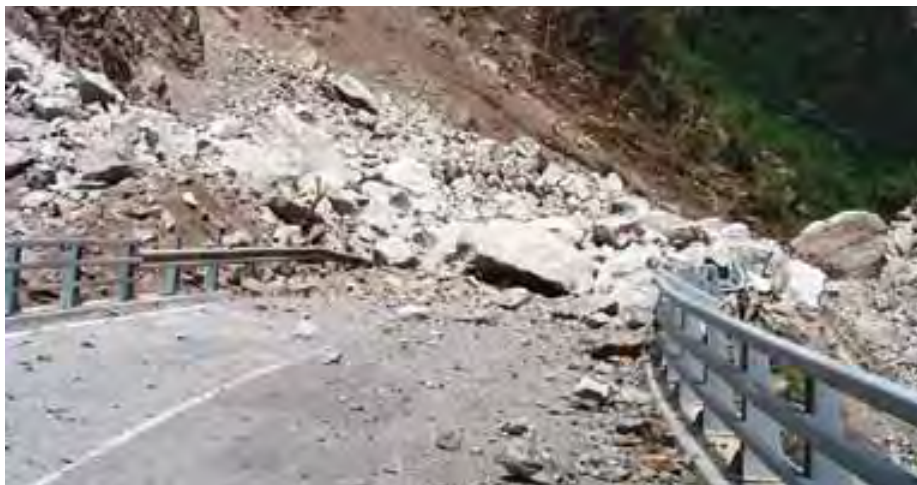
Éboulement du versant rocheux de Valabres (Alpes Maritimes)
