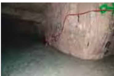
Cavité de Saint-Martin-le-Nœud (Oise)
